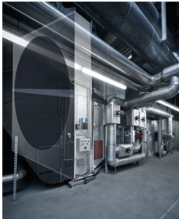
Abb. 1 // Rotationswärmetauscher (oben) Abb. 2 // Rotor in Be- und Entlüftungsanlage (unten)
